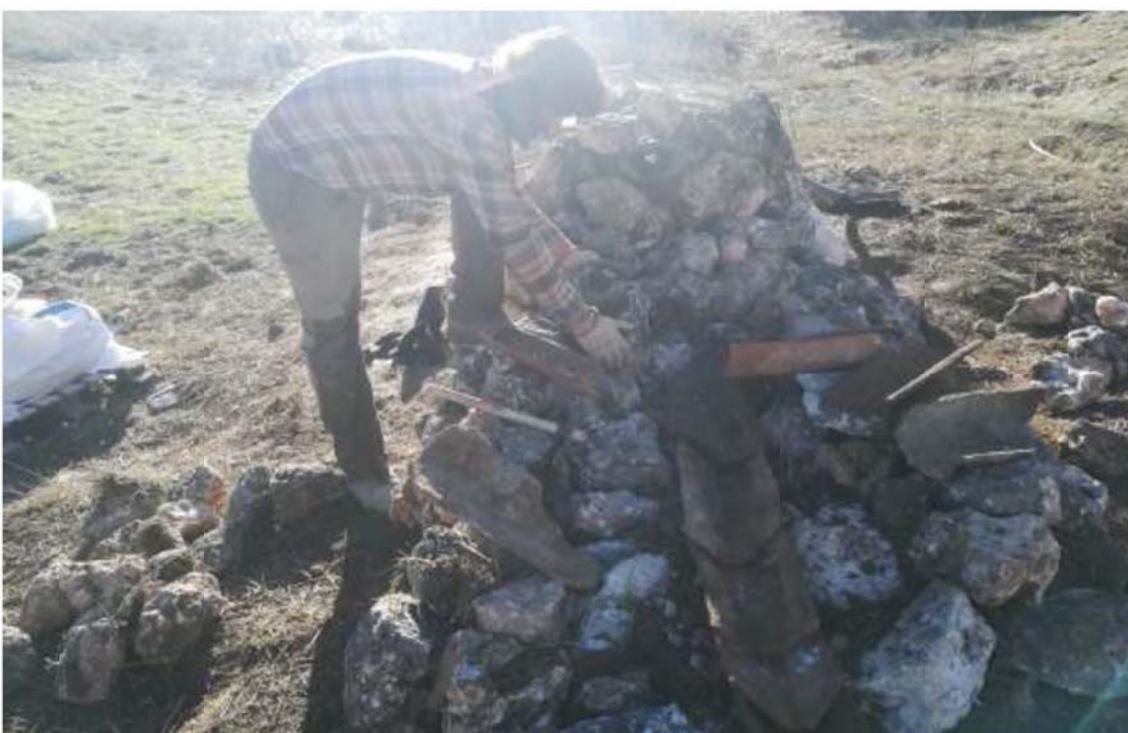
*Momento de la construcción de la canaleta con teja vieja para conducir el agua sobrante del pilón a la nueva charca.*
