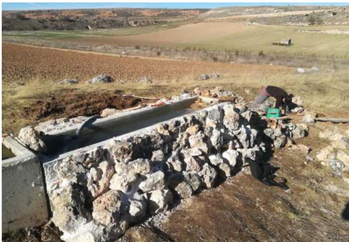
*Nuevo pilón instalado a continuación del viejo. Primera fase del trabajo de revestimiento en mampostería, en la cara este del nuevo pilón.*
