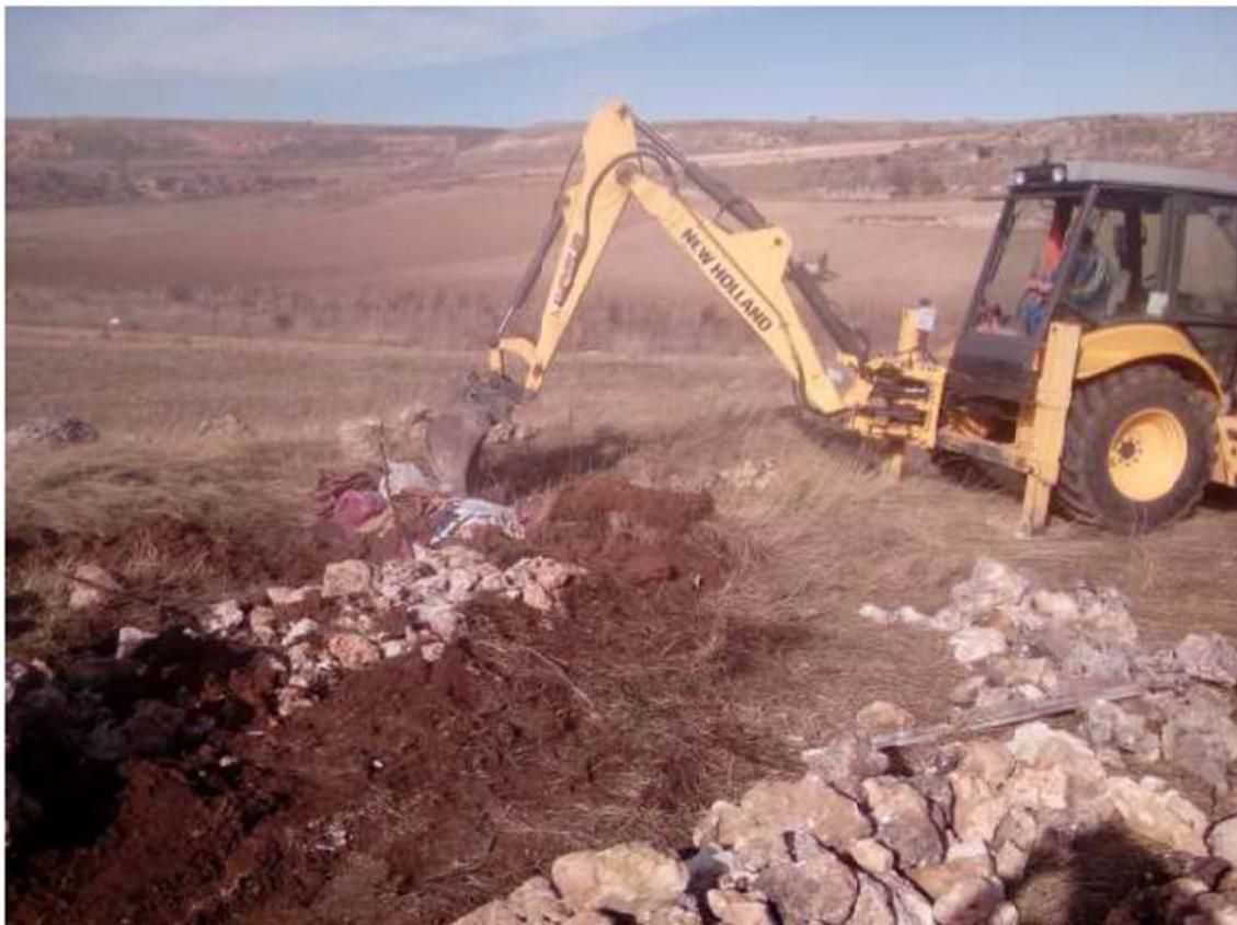
*Preparación de zanja y relleno con piedra para un mejor asentamiento del nuevo pilón adquirido.*
