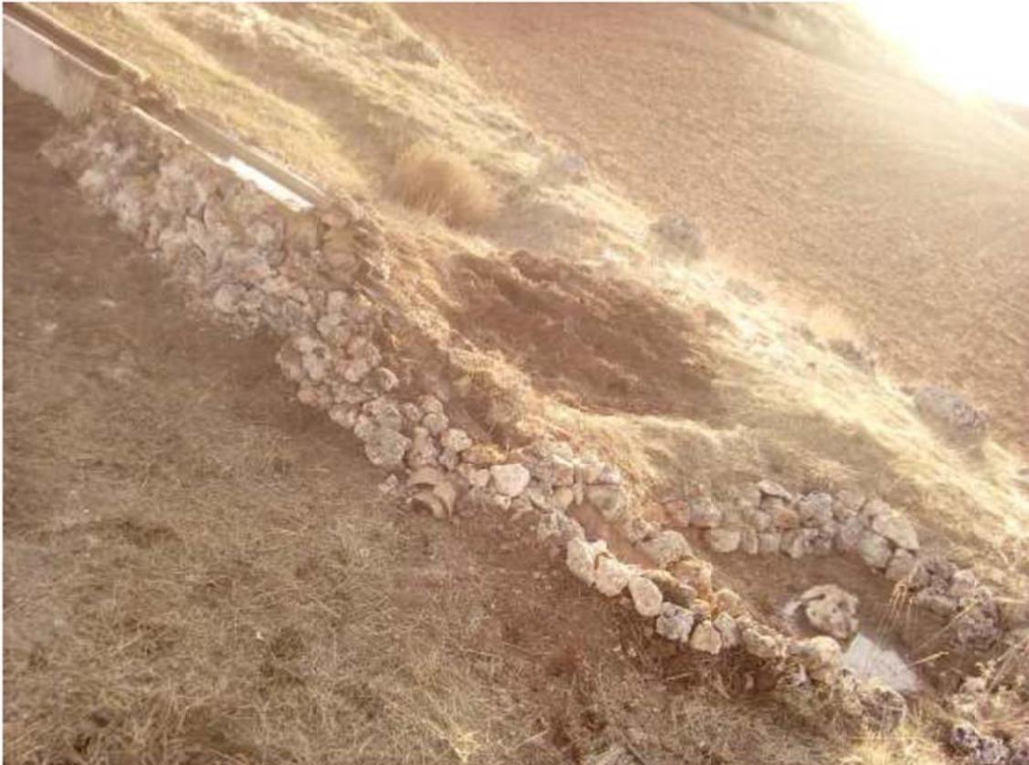
*Vista final del pilón revestido de piedra, la canaleta de teja y la charca naturalizada llenándose, antes de la instalación del cerramiento de madera de la charca.*
